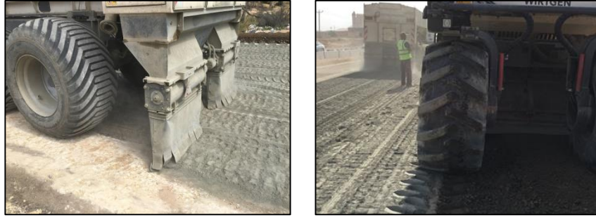
شكل 9 عملية رش الاسمنت على سطح الرصف
