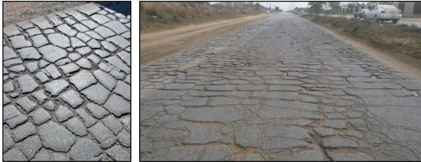
شكل 6 اضرار على سطح الرصف
